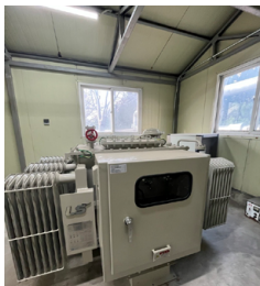
임시동력 변압기 설치사진
